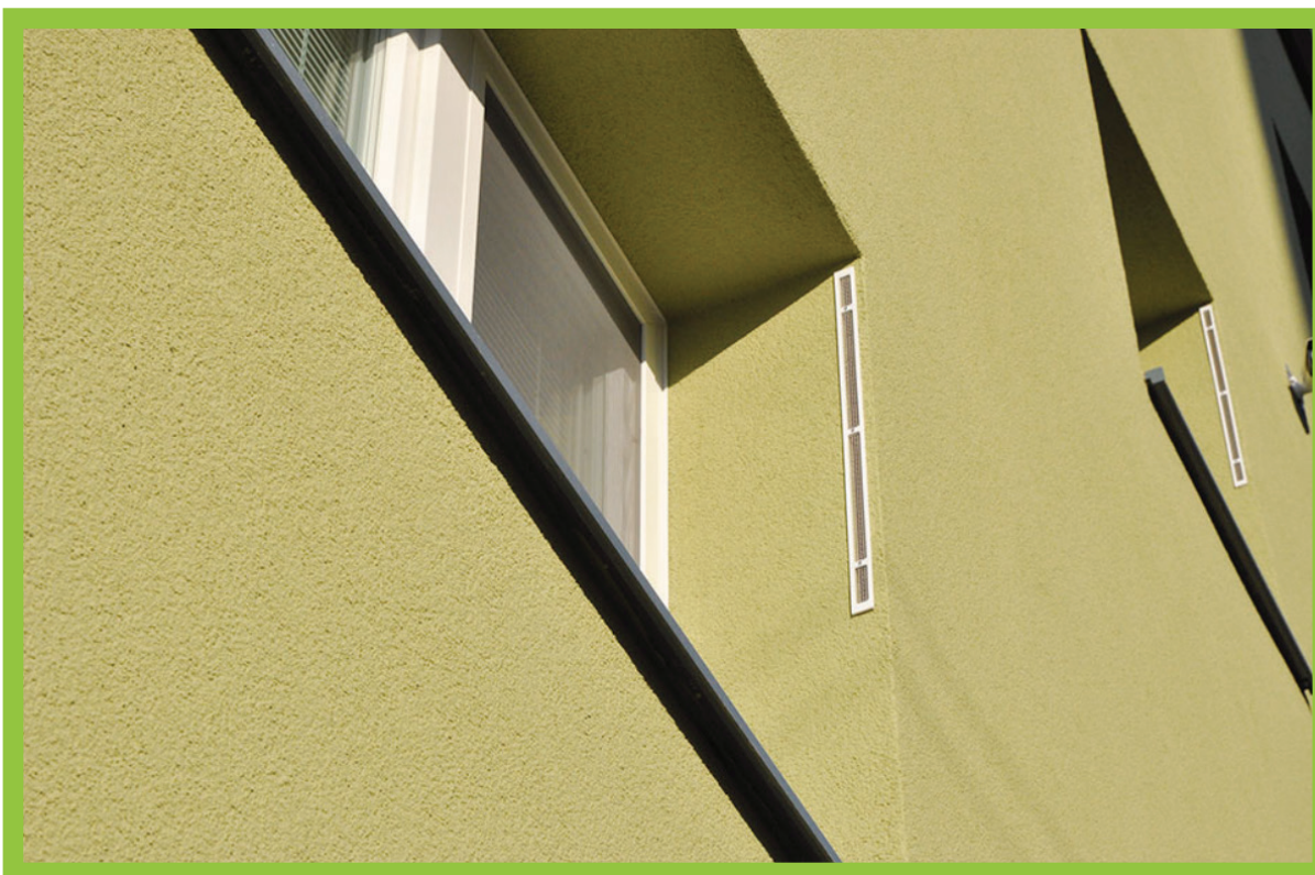
Detail ostenia bytového domu po obnove (Zdroj: asb.sk)
