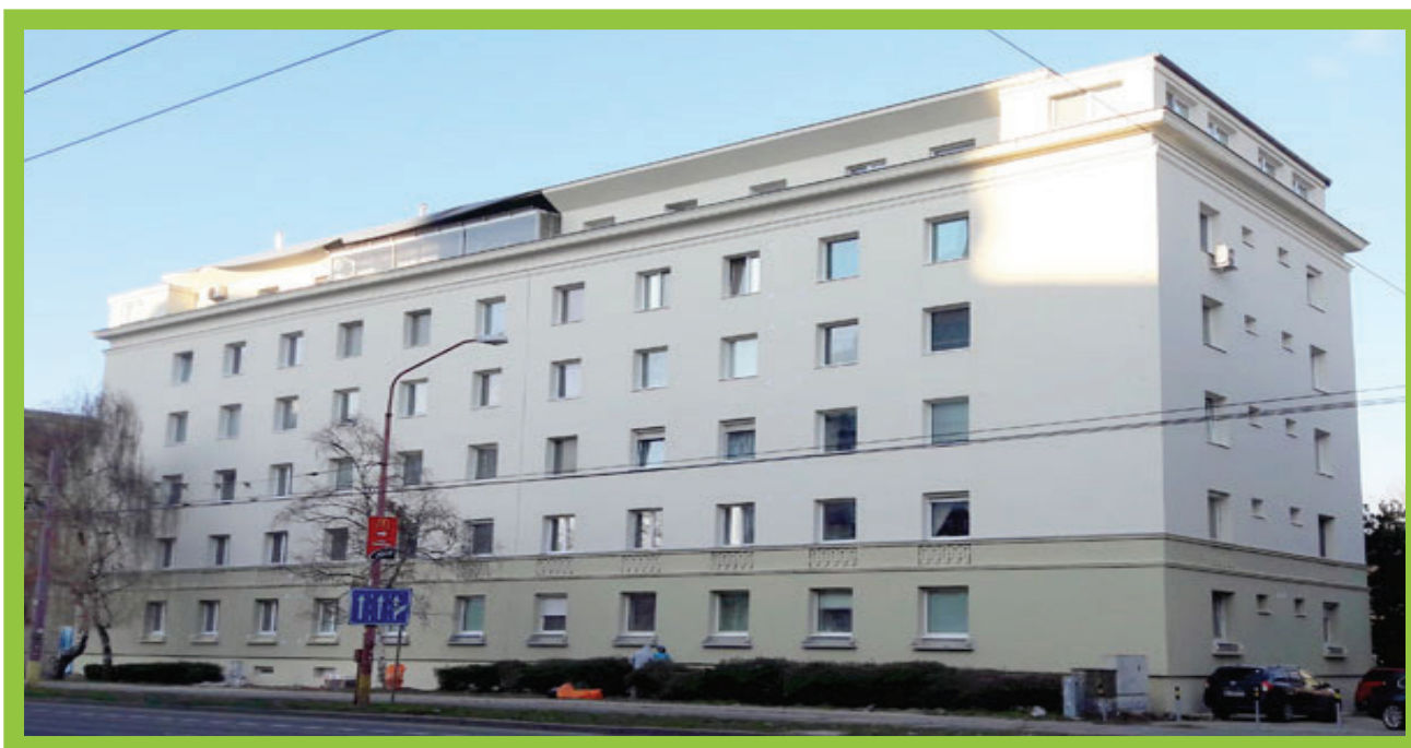
Bytový dom po obnove (Zdroj: eran.sk)
